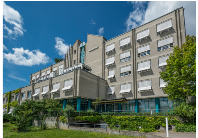
Novotechnik Ostfildern-Ruit, Produktionsgebäude
